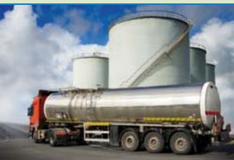
Durchflussmessung an der Füllstation mittels Impulsisolator 9202B .
